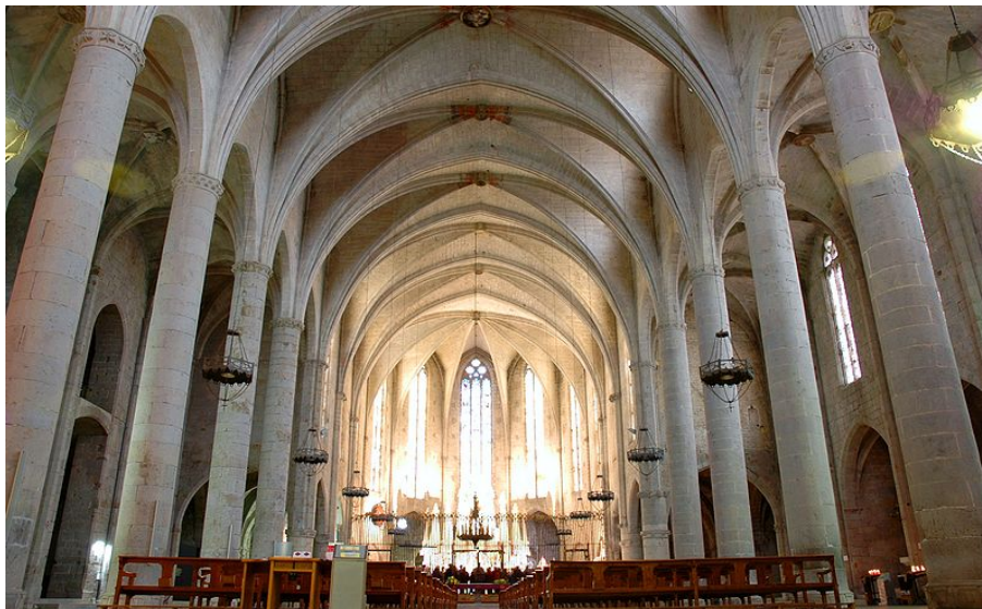
Fig. 4.16. Interior de la Iglesia de Castelló d'empuries (" la catedral del ampurdán "). Donde se aprecian las dos primeras crujías "francesas" y las siguientes "a la catalana". Fotografía de www.wikipedia.com .
