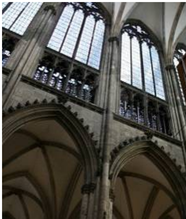
Fig. 4.21. Claristorio de la nave principal de la catedral de Colonia en la actualidad. Vitrales con vidrios transparentes.
