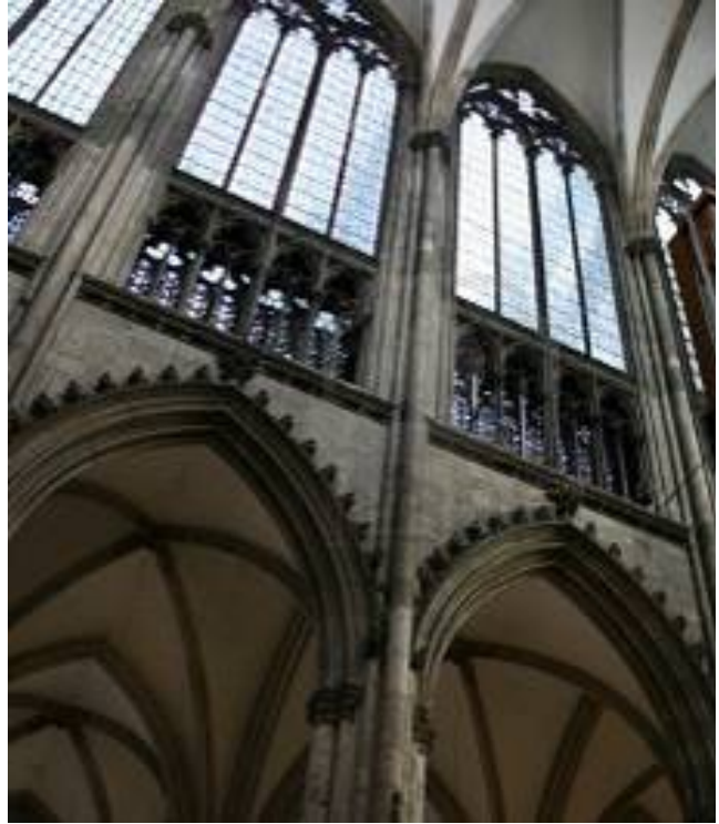
Fig. 5.69. Claristorio de la nave principal de la catedral de Colonia en la actualidad. Vitrales con vidrios transparentes.
