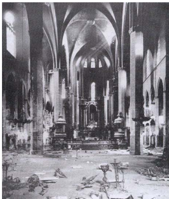
Fig. 6.49. Nave principal de la catedral de Santa María del Mar después del incendio.
